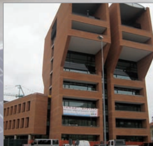
Complesso efficiente a Varese
